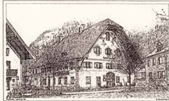
Der Hofwirth zur Post vor der Sanierung im Jahre 1997
